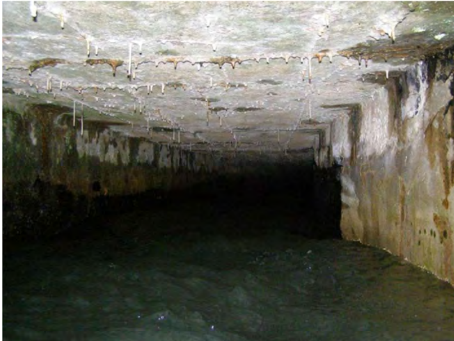
Slika 1.1.-3. Unutrašnjost dovodnog kanala
