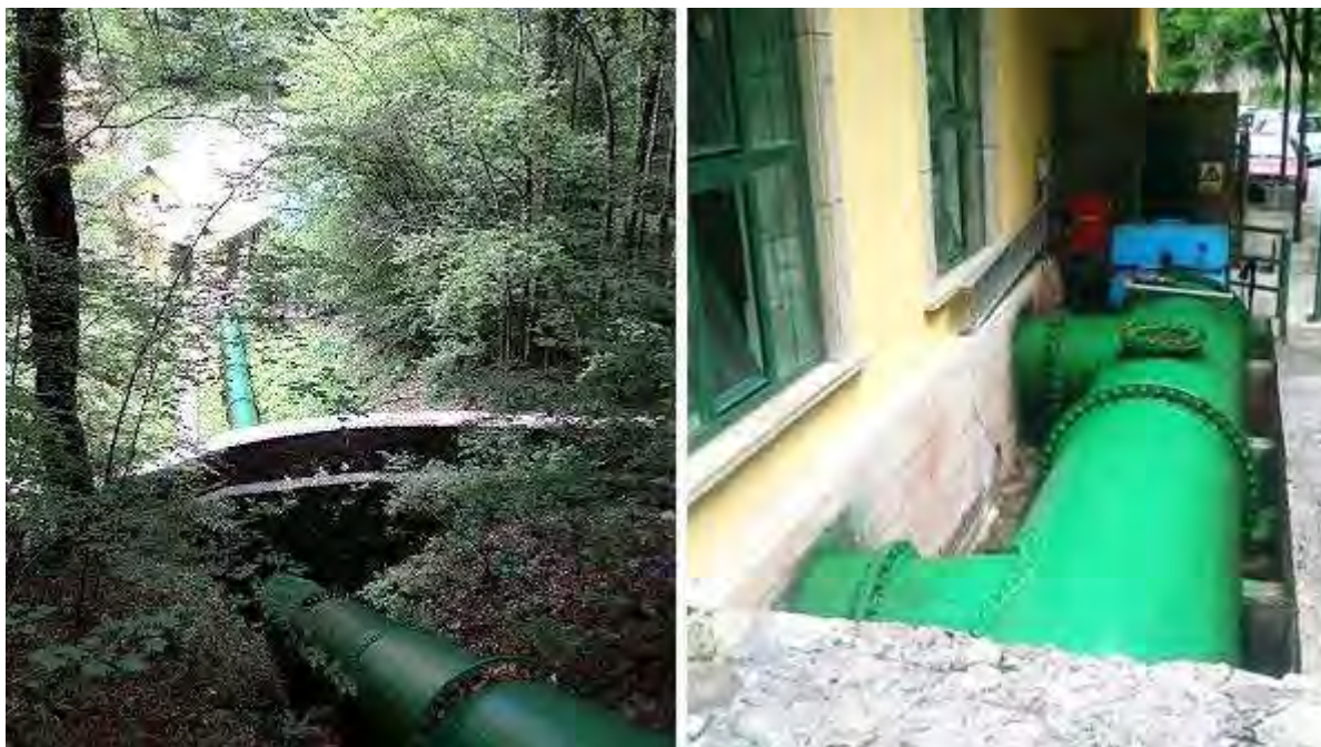
Slika 1.1.-6. Tlačni cjevovod i račva HE Zeleni vir
