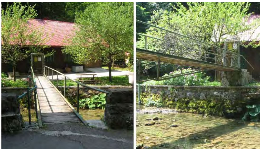
Slika 1.1.-8. Postojeći most na lokaciji zahvata
